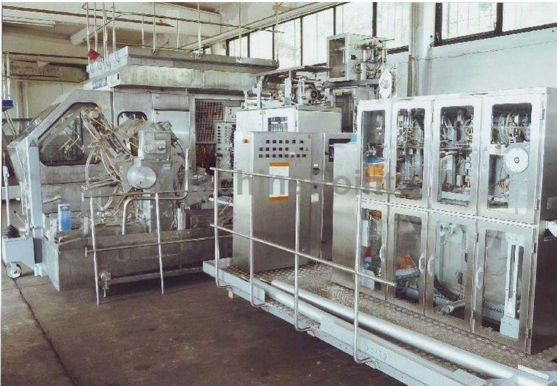
Abb. 10: Aktuelle Klimaanlage der Produktionsabteilung
