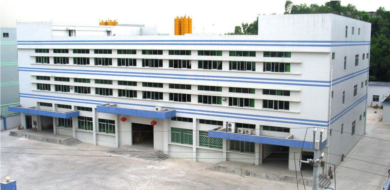
Abb. 13: Außenansicht Verwaltungsgebäude (Beispielfoto)
